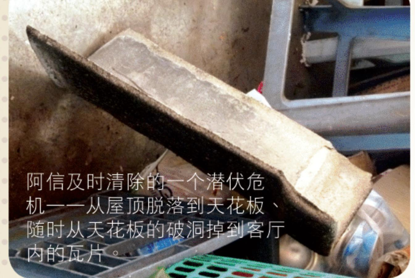
阿信及时清除的一个潜伏危机——从屋顶脱落到天花板、随时从天花板的破洞掉到客厅内的瓦片。
